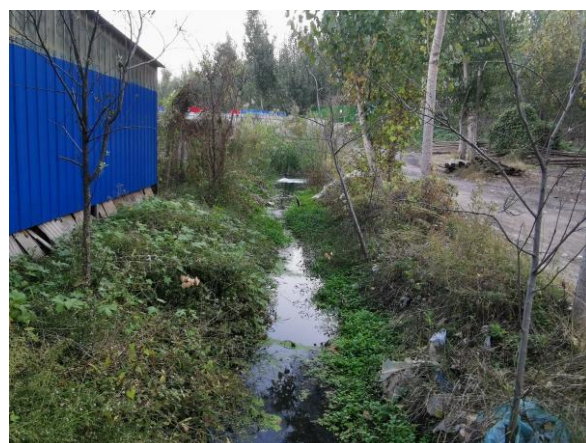
图 3.2-4 龙王庙排水沟
